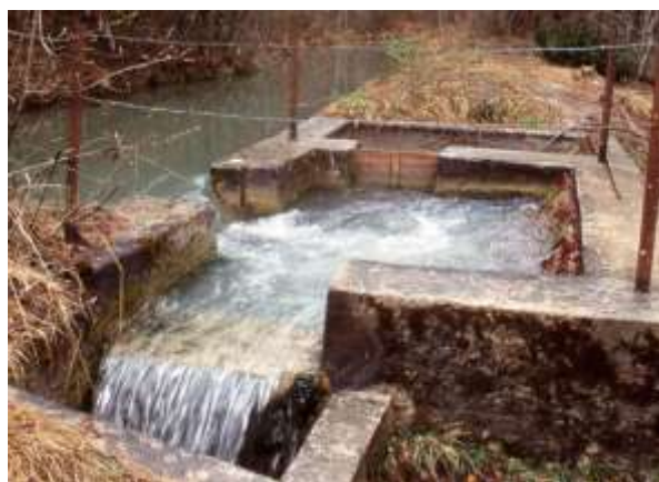
Fosse de répartition
