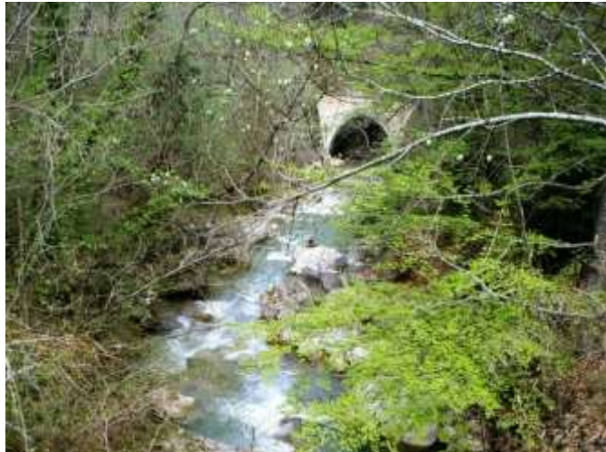
En aval, on distingue le tunnel sous le ballast de l'actuelle route RD 1075 permettant le passage du torrent l'Orbanne.
