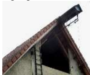
Les montoirs ont généralement été rajoutés lors des modifications de toitures et de surélévation de murs qui donnaient un volume plus important à la grange.
