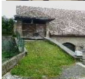
Les grandes lucarnes du Trièves étaient utilisées pour monter le foin sous le toit quand il n'existait pas de montoir, à l'aide d'un système de cables et de poulies.
