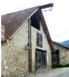
Les grandes lucarnes du Trièves étaient utilisées pour monter le foin sous le toit quand il n'existait pas de montoir, à l'aide d'un système de cables et de poulies.
