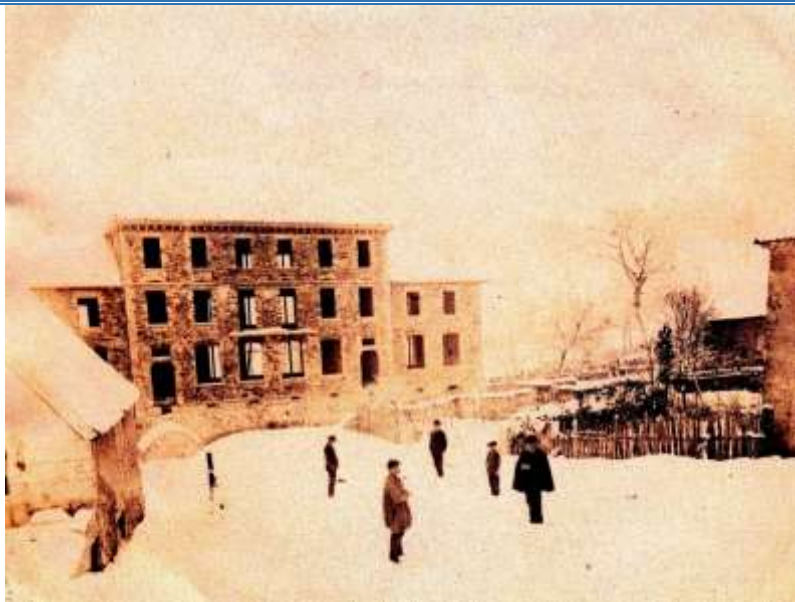
Chantier mairie-écoles de Clelles / hiver 1894
