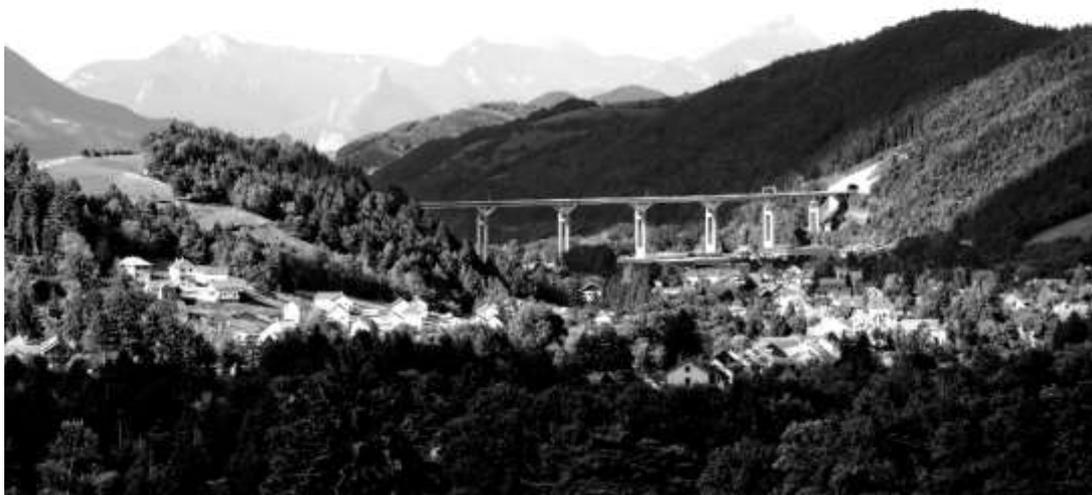
La route 75 passe au-dessous de ce viaduc qui est une prouesse technique car les piles centrales reposent sur des terrains d'alluvions glaciaires (argiles litées du lac wurmien). L'ouvrage est sous surveillance constante par capteurs.
