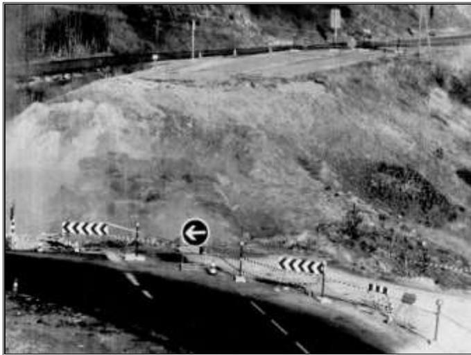
En 1995, gros effondrement sur le nouveau tracé de 1974 (point 8 de la photo aérienne), qui nécessite deux ans de travaux ... la déviation reprend l'ancien tracé (point 1 ci-dessus).
