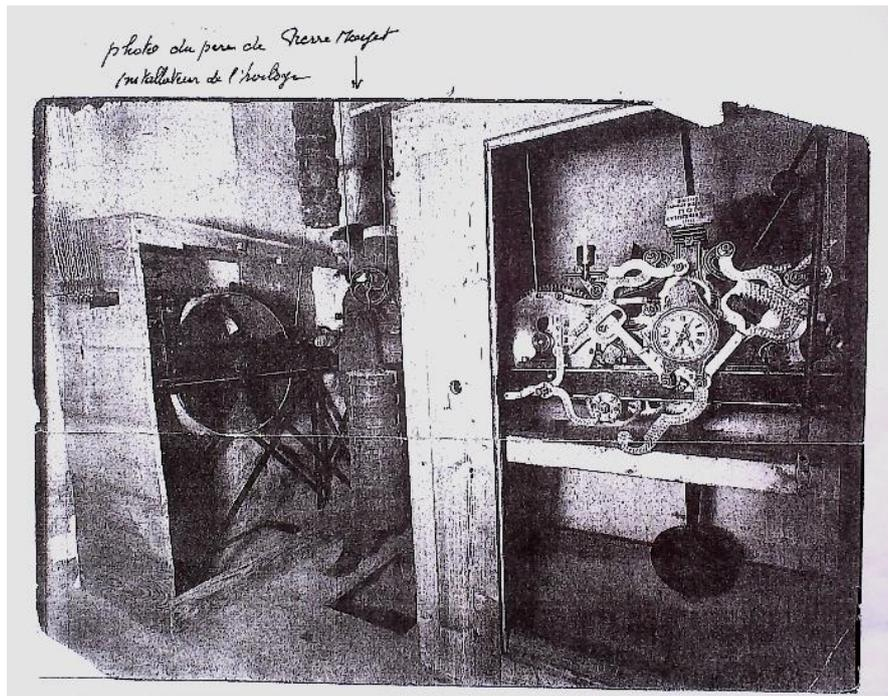
A gauche, la machine à carillonner, protégée à l'origine par un cabinet en bois, on aperçoit les touches et les cables à l'extrême gauche.
