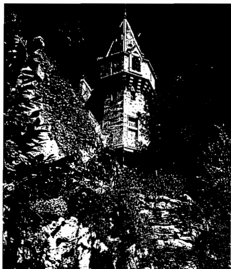
Le château de Beurevoir émerge d'une rocaille mêlant pierre et ciment
