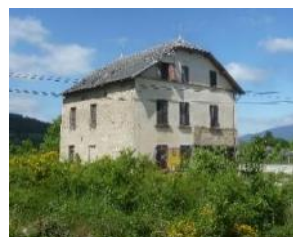
Les grandes lucarnes du Trièves étaient utilisées pour monter le foin sous le toit quand il n'existait pas de montoir, à l'aide d'un système de cables et de poulies.
