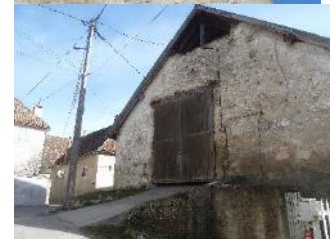
Les montoirs ont généralement été rajoutés lors des modifications de toitures et de surélévation de murs qui donnaient un volume plus important à la grange.
