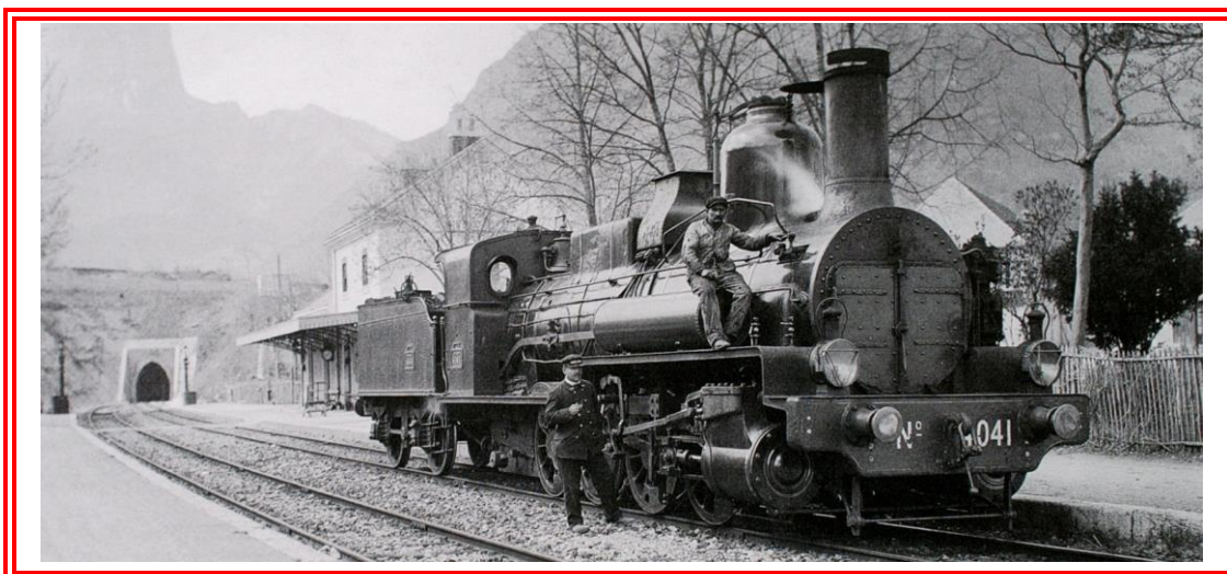
Locomotive « série 4000 » en gare de Clelles : ici la loco n° 4041. [collection particulière Bonfils] En arrière-plan, l'entrée du tunnel, le réservoir et la base du Mont aiguille.
