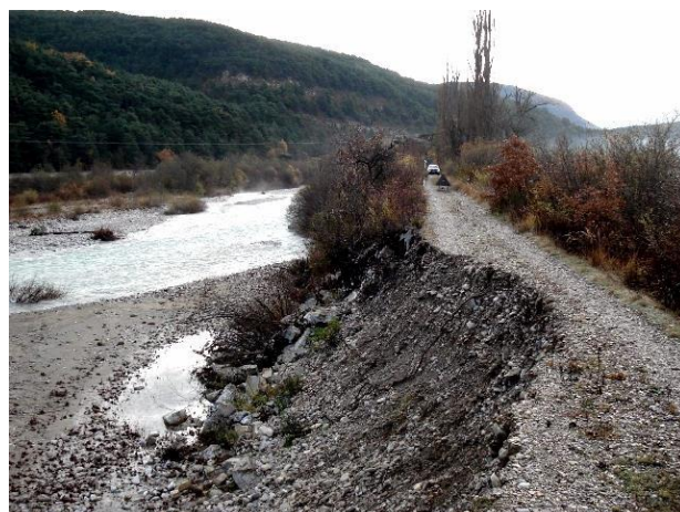
Digue du Buëch à La Faurie (05)
